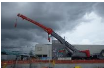
ラフタークレーンによる施工
